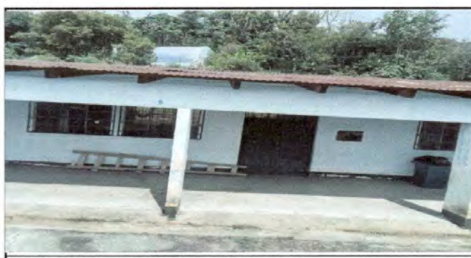
Foto 5: Pintura en muros exterior e interior
