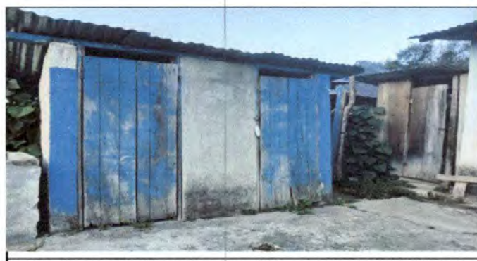
Foto 6: Sustrucción de puertas en servicios sanitarios (2 unidades m2.)
