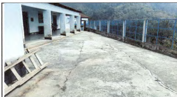
Foto 3: Losa de patio de reparación de plancha de cemento de 185. m2.
