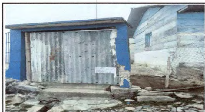
Foto 4: mantenimiento a porton de metal de 4 mts
