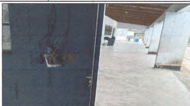
Foto 8: Reparación de cableado eléctrico 50 mts.
