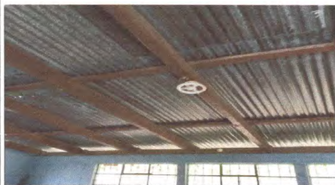
Foto 9 Sustitución de lámpara de 120V 22w (1)
