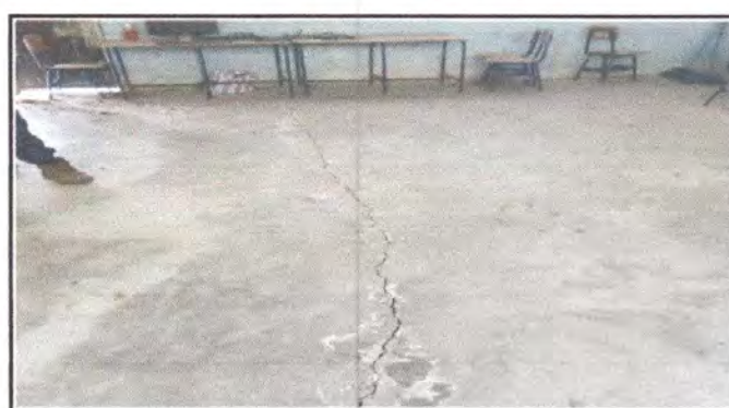
Foto 10 Reparación de piso de torta de concreto (48 mts)
