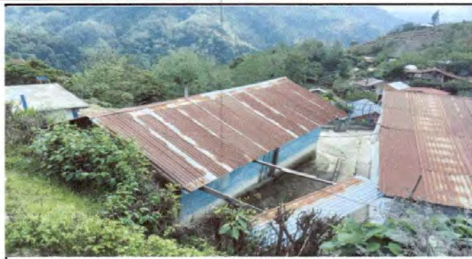
Foto 2: Sustrucción de lámina troquelada aluzinc calibre 26 90 mts y sustrucción de capote de lámina para lámina troquelada 5
